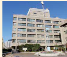
現在の品川区役所本庁舎
