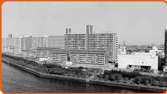
建てられたばかりの八潮団地(昭和58年撮影)
