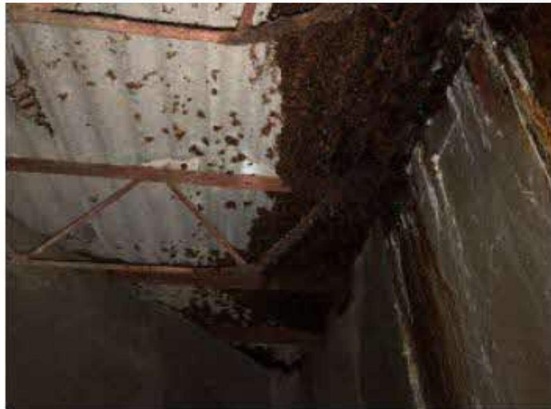
[写真 9-2] トンネル水槽下漏水と躯体劣化
