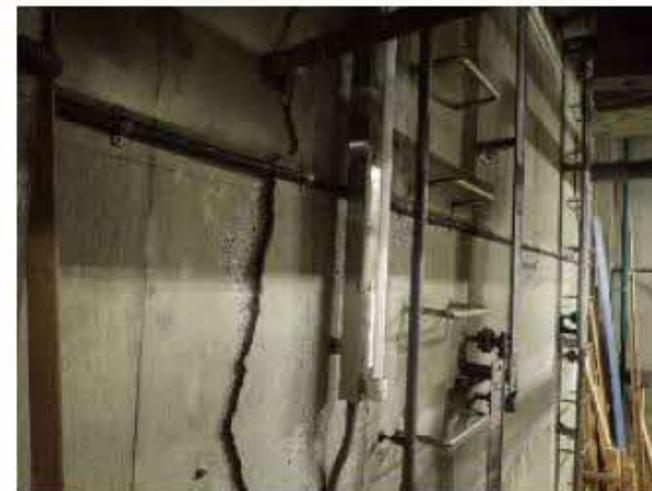
【写真 13】 受水槽外壁のひび割れ
