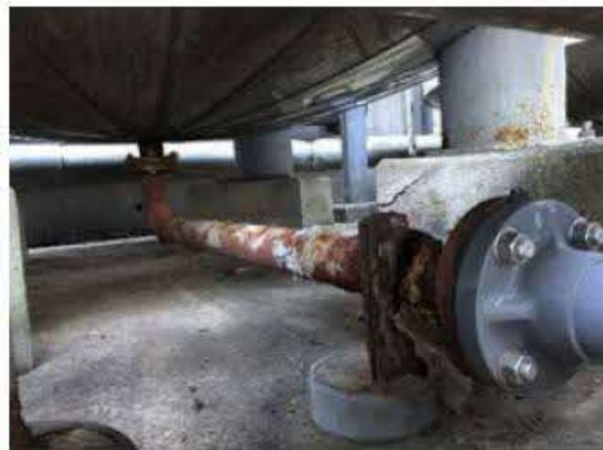
【写真 11】 隠蔽部の配管の腐食
