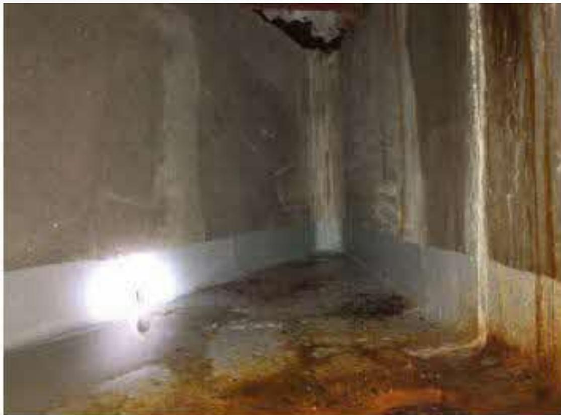
[写真 9-1] トンネル水槽下漏水と躯体劣化
