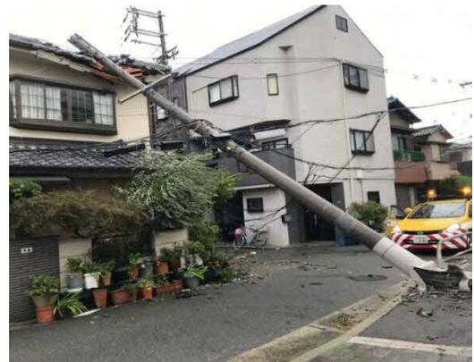
図6 台風21号により倒壊した大阪府内の電柱
