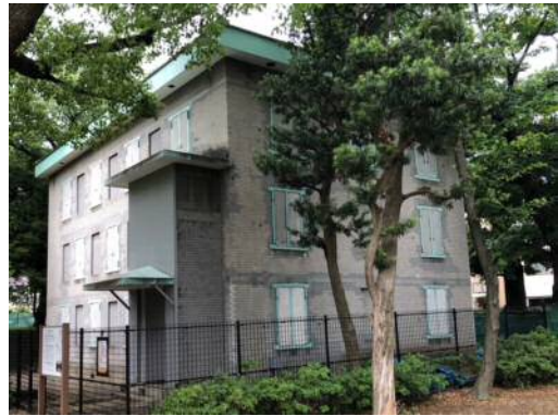
書庫外観（南東より）
