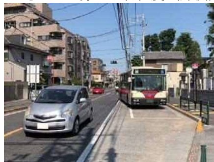
図 3-9 バス停留所（バスベイ）の設置例
