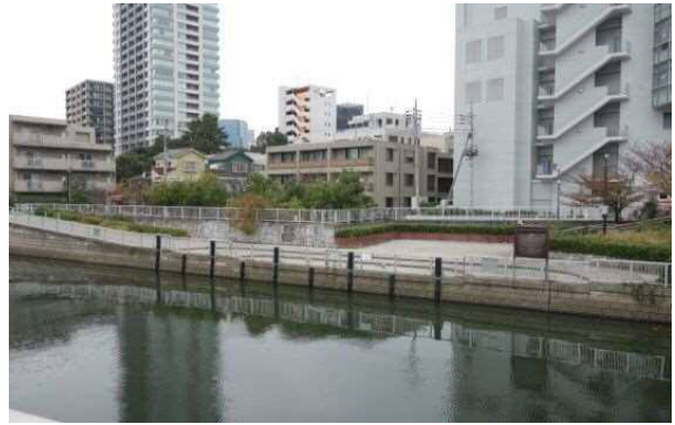
東海橋防災船着場（改修工事）
