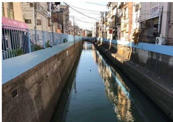
設置状況（国道15号線より上流）
