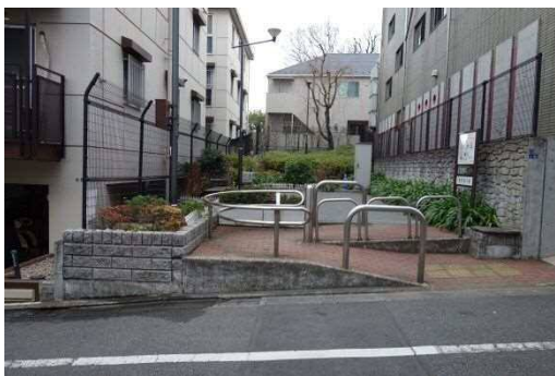
暫定貯留施設整備位置
