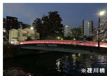
【平成 30 年度整備した 3 橋】
