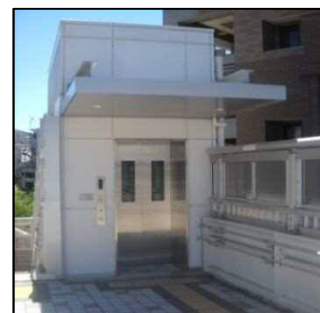
【百反歩道橋エレベーター】
