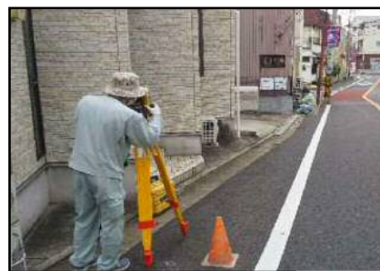
測量実施状況
