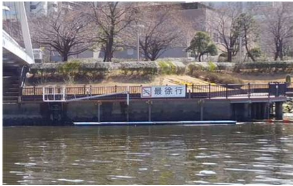
東品川海上公園棧橋（整備工事）
