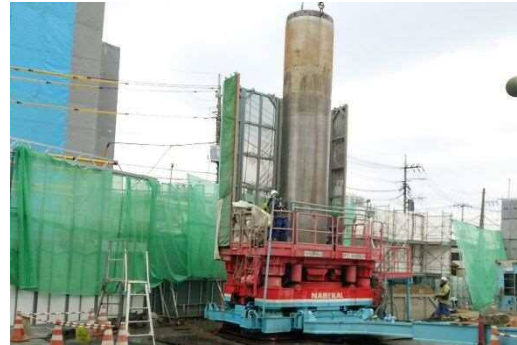
上流部発進立坑整備状況
