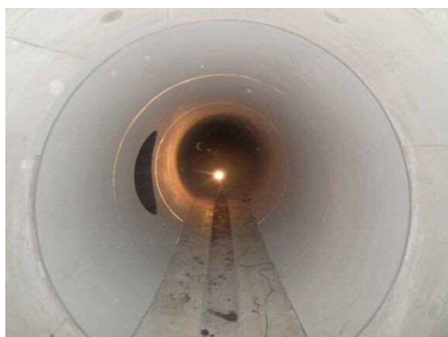
完成した排水管（内径 2.8m）
