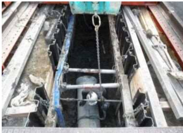
開削工法写真（布設替え）
