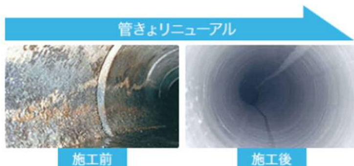
管きょ更生工法写真
