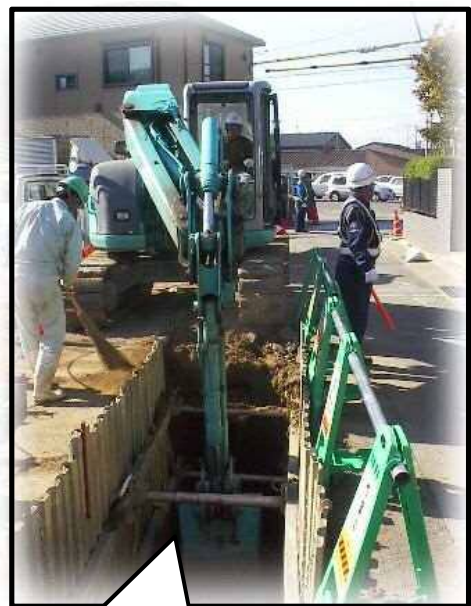
開削工法写真 (布設替え)
