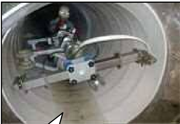
管きよ更生工法 (SPR工法) 写真
