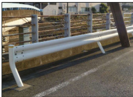
防護柵（ガードレール）
