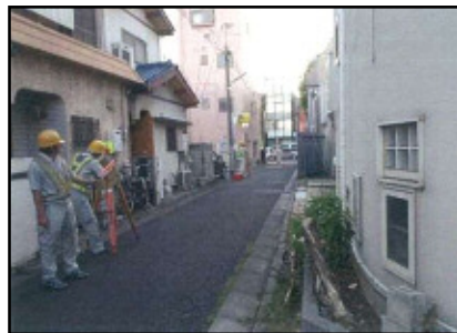
上の写真：測量実施状況
