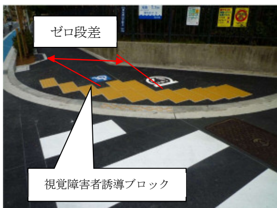
歩道平坦化実施箇所
