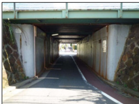
碑文谷架道橋 (施工前)
