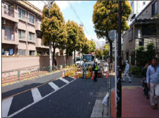
池上通りのマンホール工事の状況
