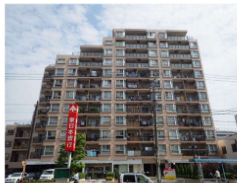
津波避難施設：ステーションプラザ立会川
