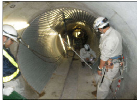
雨水貯留管の工事状況
