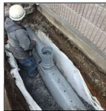
浸透枡設置状況
