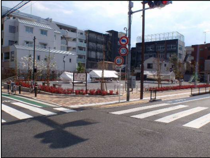
【二葉3・4丁目、西大井6丁目地区 西大井六丁目ふれあい広場完成写真】
