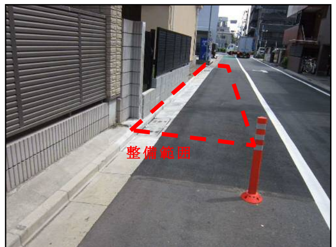
【東中延1丁目 拡幅道路整備後】
