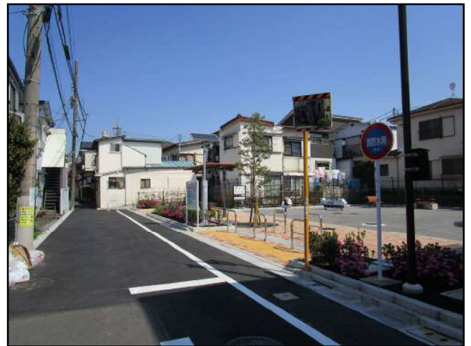
【豊町4丁目 広場整備後】
