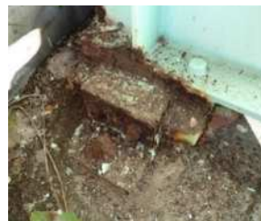
損傷事例(支承の腐食)
