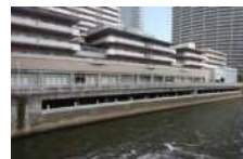
荏原調節池取水部
