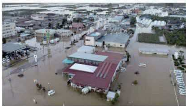
令和元年東日本台風による被害（出典：国土地理院 HP）
