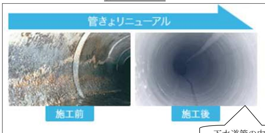
下水道管の内面を樹脂材で補強
