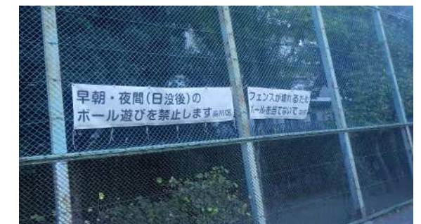
キャッチボール場 看板設置状況
