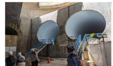
立会川雨水放流管の整備状況
