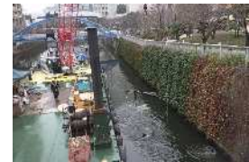
障害物撤去実施状況
