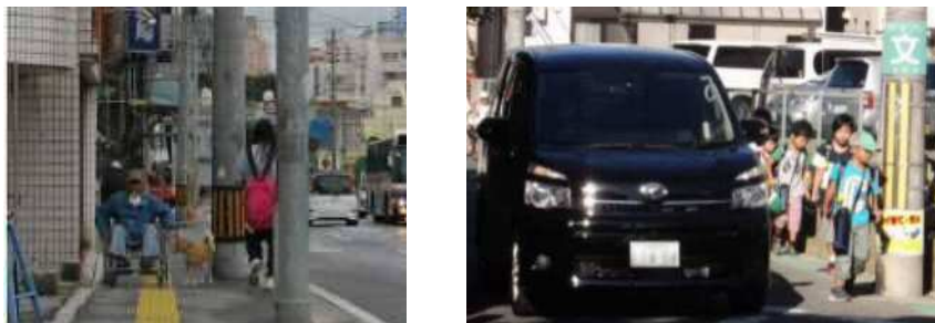
図8 歩行者の通行を妨げる電柱の例
