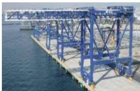
耐震強化岸壁・免震クレーン
