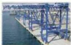
耐震強化岸壁・免震クレーン
