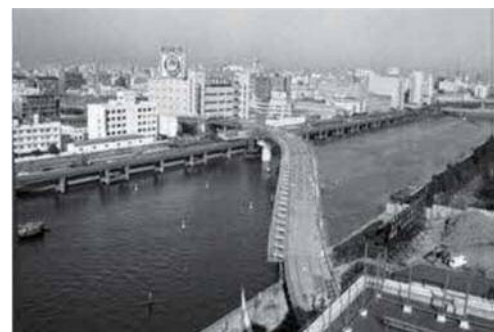
▲建設中の八潮橋
