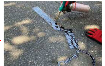
路面修繕作業
