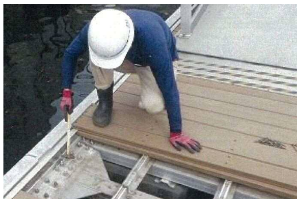
船着場詳細調査状況
