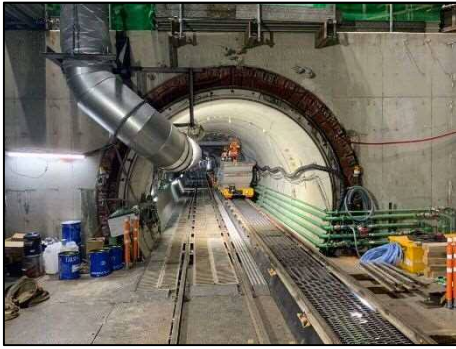
下流部下水道本管坑口
