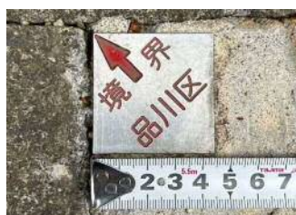
境界を示す標識（プレート）
