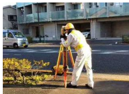
測量実施状況
