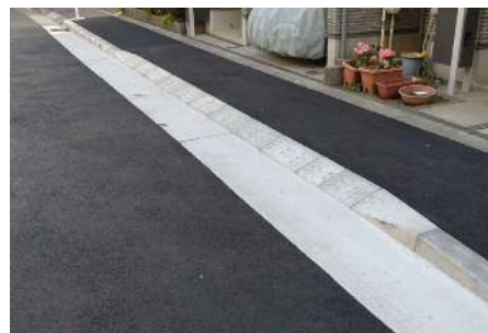
歩道切下げ工事例 (車の出入りのため、歩道のブロックを斜めにする等の工事)
