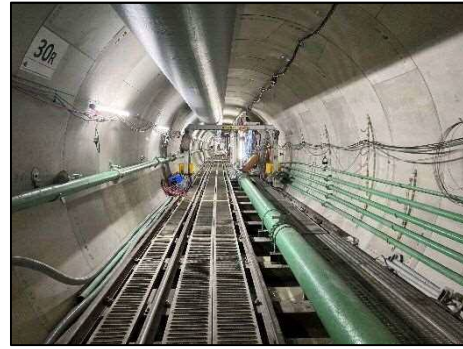
下流部下水道本管内
