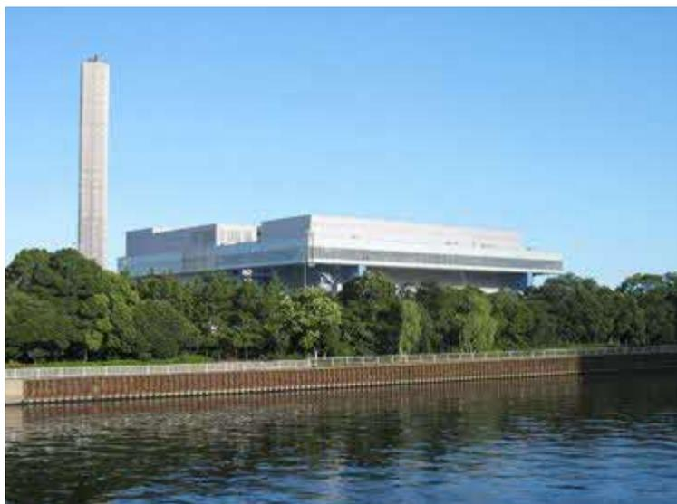
区が収集した「燃やすごみ」を焼却する施設で、ごみ焼却で発生する熱を利用し発電を行うほか、高温水は熱供給事業者に送り、八潮団地内の空調、各種の熱源に利用されています。
