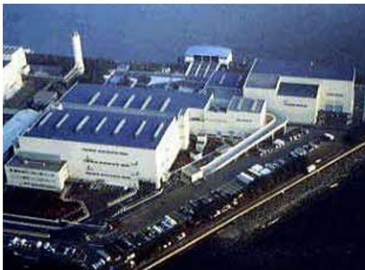
区が収集した「陶器・ガラス・金属ごみ」を処理する施設で、鉄、アルミニウムを機械選別で取り出し再資源化するほか、資源化物を回収した残りのごみを破碎するなど、不燃ごみの容積を減らしています。
