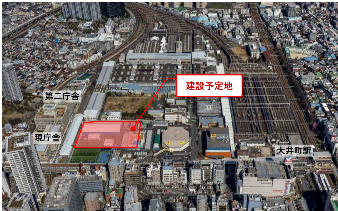
図表 3-2 建設予定地の現況
