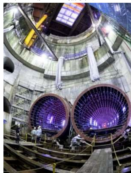
立会川幹線雨水放流管（工事中）
