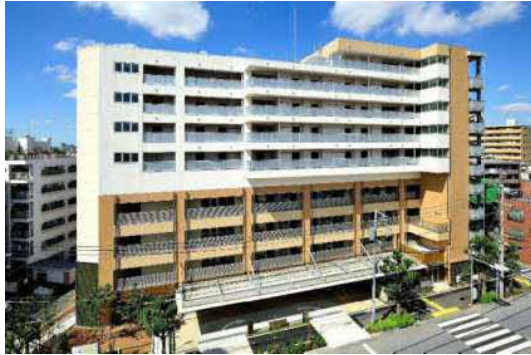
西中延区営住宅
