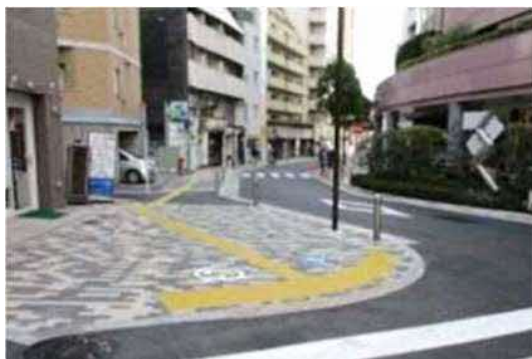
バリアフリー化された道路
