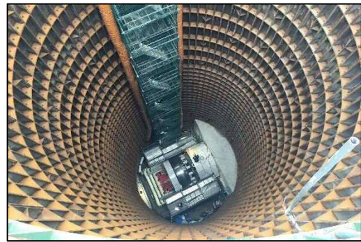
シールド掘進機 現地組立状況
