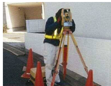
測量実施状況
