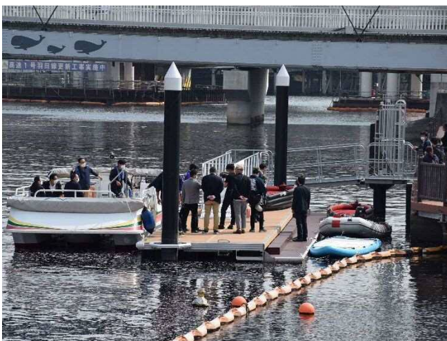
東品川海上公園船着場（令和3年度整備）
