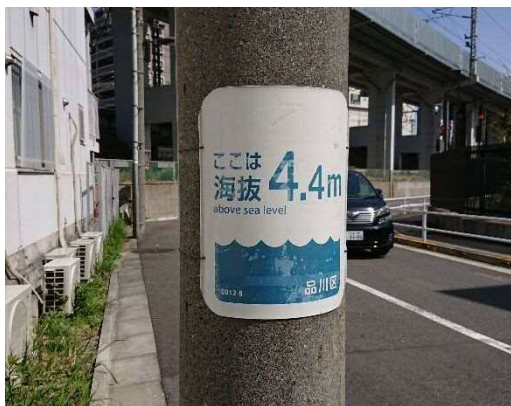
老朽化した海拔表示板
