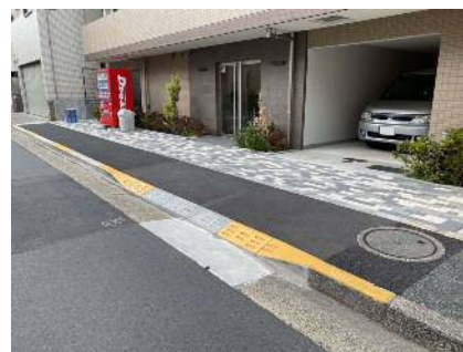
歩道切下げ工事例 (車の出入りのため、歩道のブロックを斜めにする等の工事)
