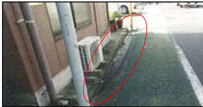
【側溝の修繕（水たまりの解消）】
