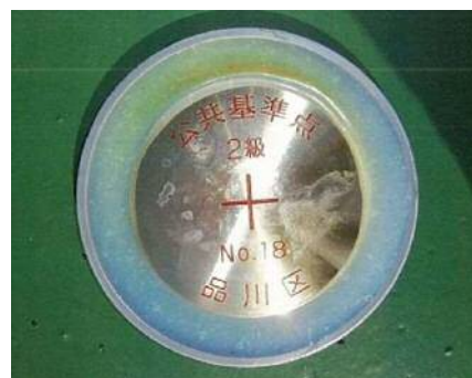
2級基準点標識 (3級基準点も同形状)
