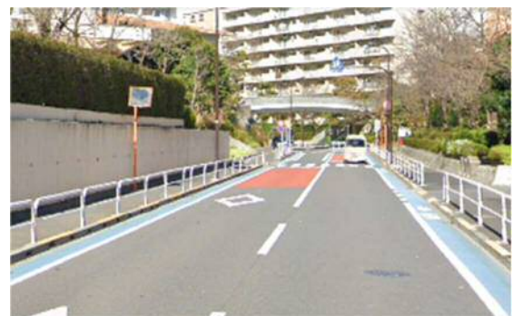
▲ 改修された区道
