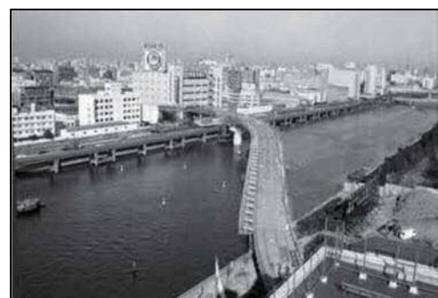
▲建設中の八潮橋
