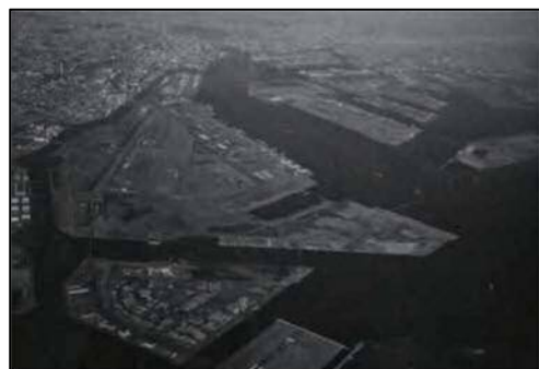
▲東京湾埋め立て工事の航空写真（昭和 56 年）
