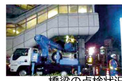
橋梁の点検状況 （大森駅歩道橋）
