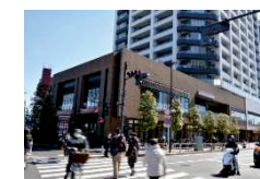
ビル低層部の生活支援施設 (大井町西地区)
