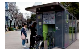
地下機械式駐輪場 （大森駅水神口）
