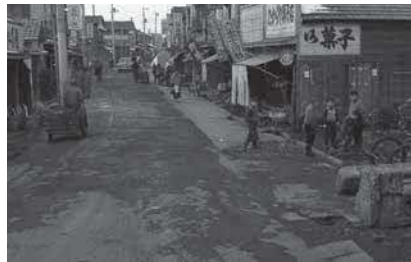
品川用水の暗渠工事後 後地交番付近(昭和31年) (パネル展示)
