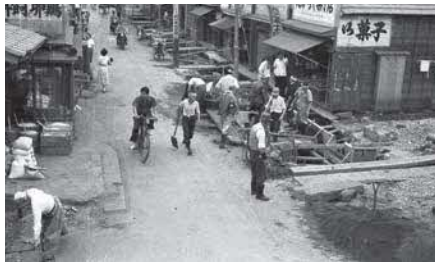
品川用水の暗渠工事 後地交番付近(昭和29年) (パネル展示)
