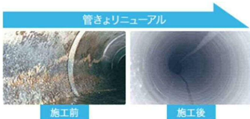
下水道管の内面を樹脂材で補強
