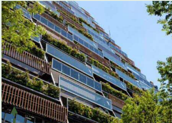
エコヴェール：太陽光発電パネル、緑化パネルで構成
