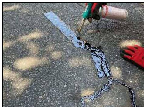
補修シールによるひび割れ補修作業
