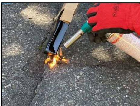
補修スティックによるひび割れ補修作業
