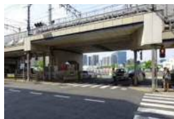
補助26号線と区画道路の交差点
