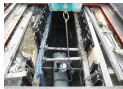
開削工法（布設替え）
