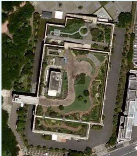
■ 東品川ポンプ所
