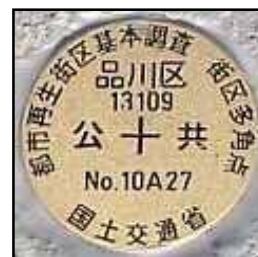
街区多角点標識
