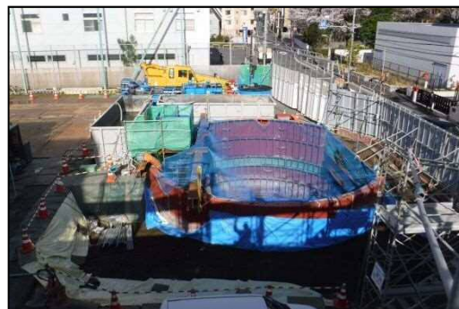
上流部発進立坑整備状況
