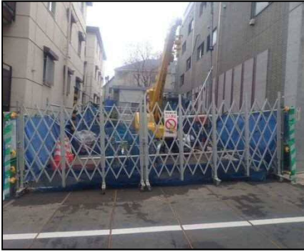
暫定貯留施設整備位置
