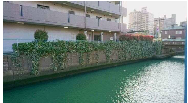
設置予定箇所
