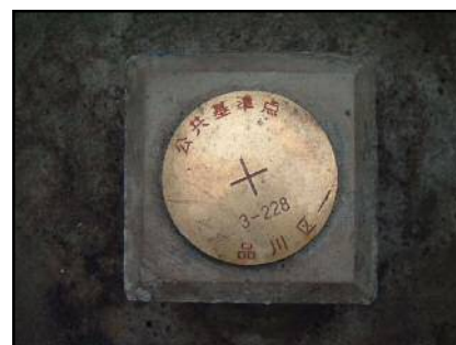
3級基準点標識 (2級基準点も同形状)
