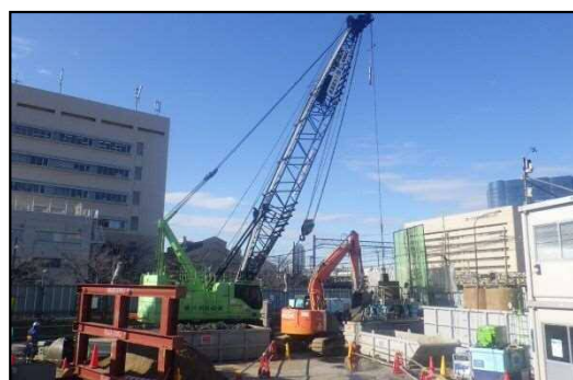
下流部発進立坑整備状況
