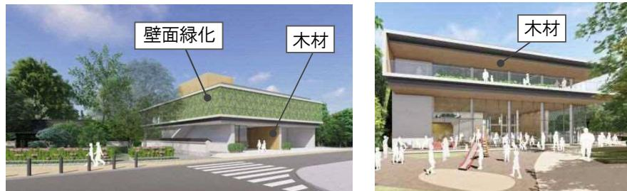
建物構造は鉄骨造ですが、建物の外装および内装の仕上げ材に木材を使用することで、木のぬくもりを演出することにあわせ、壁面緑化により周囲の自然との調和を図ります。
