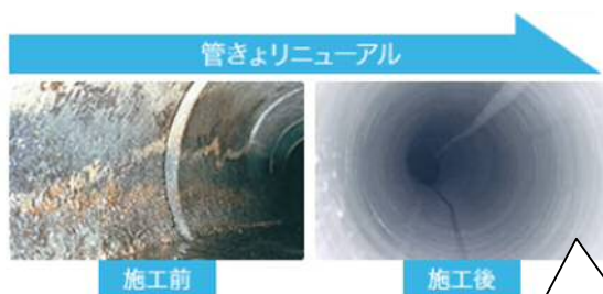
管きよ更生工法
