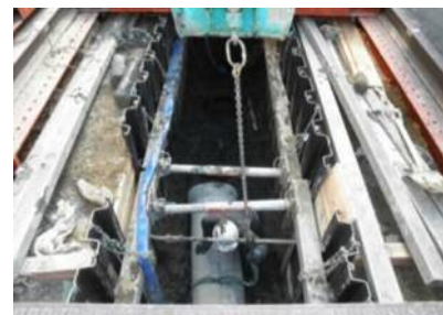
開削工法（布設替え）
