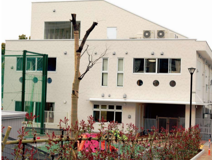
国の特区制度を活用し公園内に設置された「まなびの森保育園西大井」
