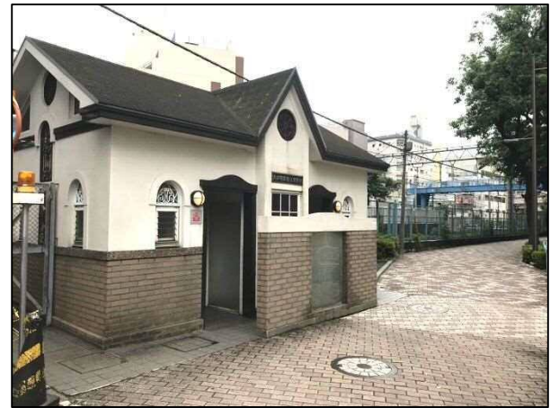
公衆便所現況写真
