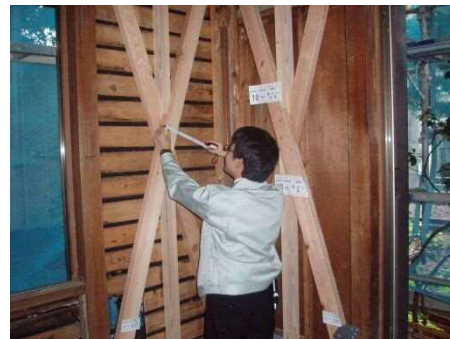
耐震改修工事の様子
