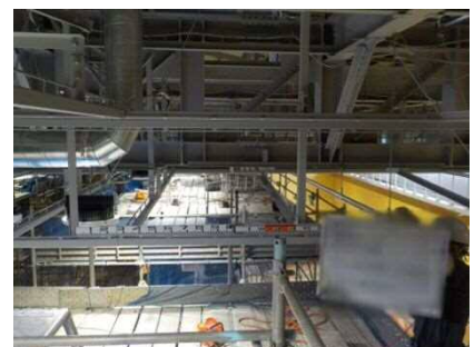
区有施設の天井落下防止対策工事の様子
